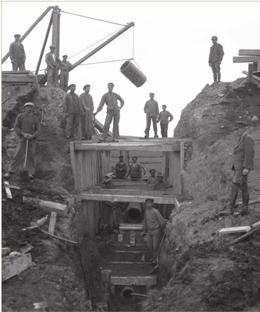
Bild nr 35 395 Kulvertarbete genom väg- eller järnvägsbank
